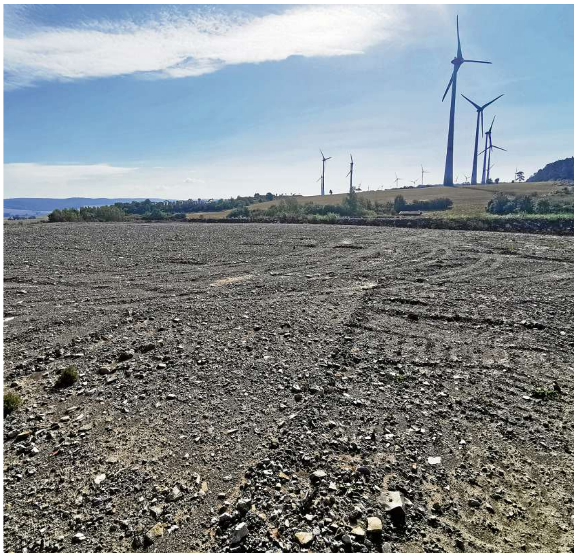
Große Flächen der Deponie Mihla sind abgedeckt. Neue Flächen sollen erschlossen werden. FOTO: JENSEN ZLOTOWICZ
